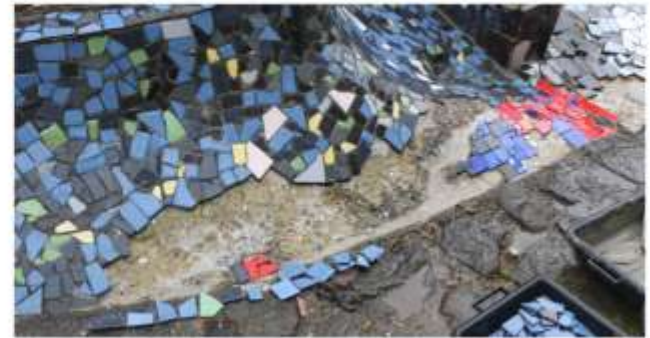
Réstauration avant et après
